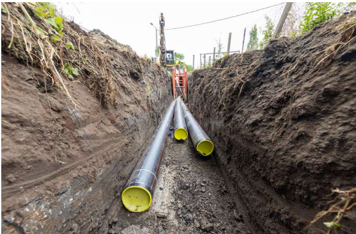
Pose de câbles souterrains en fourreaux polyéthylène haute densité (PEHD) en zone rurale
